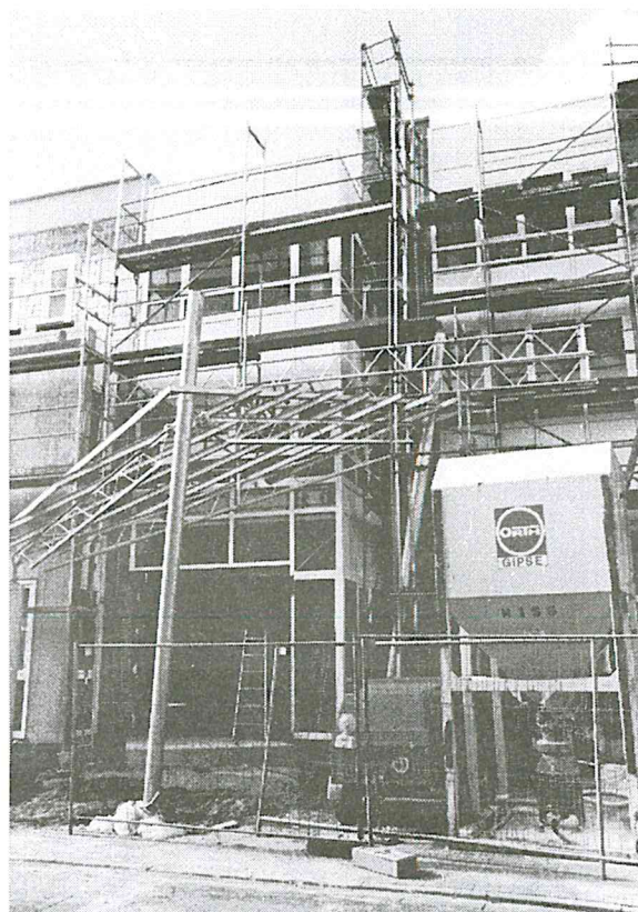
So sieht der Eingangsbereich während der Bauphase aus
